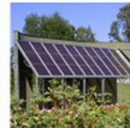
Implantation sur un appentis adossé à un mur
